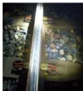
rail après meulage
