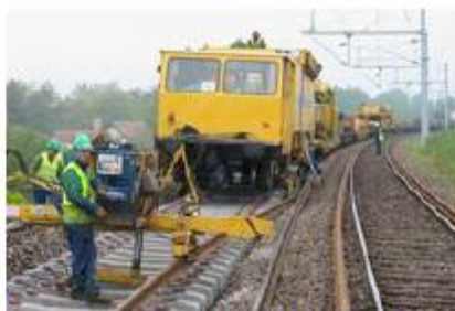
Longs Rails soudés sur traverses béton
