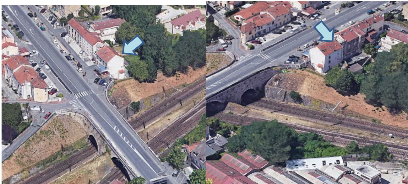
Vues de la maison de Sud-Ouest et de Sud-Est.
