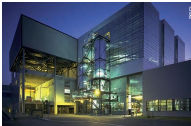
Le centre intégré de traitement des déchets de Vert-le-Grand sera l'un des principaux fournisseurs de chaleur à Grand Paris Sud dès 2019.
