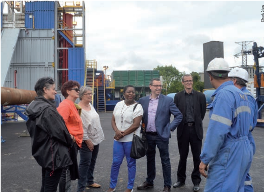
Les élus de Grigny sur le chantier de la géothermie : livraison de chaleur prévue pour l'hiver 2017.
