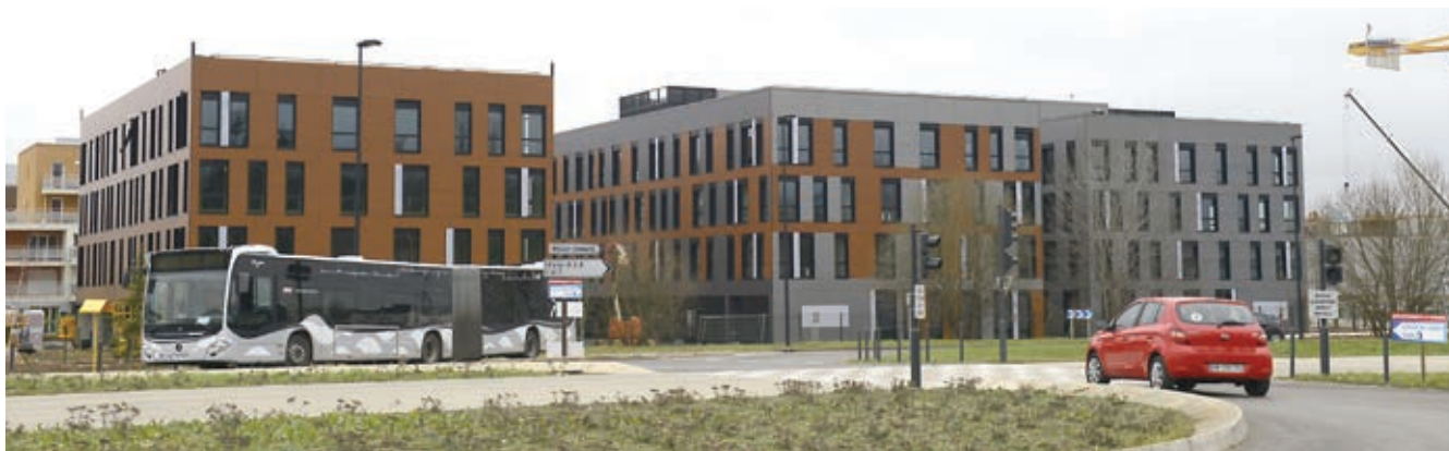
L'entreprise Ballestrero et l'ARS 77 occupent déjà une partie des immeubles de l'opération Spirito Verde
