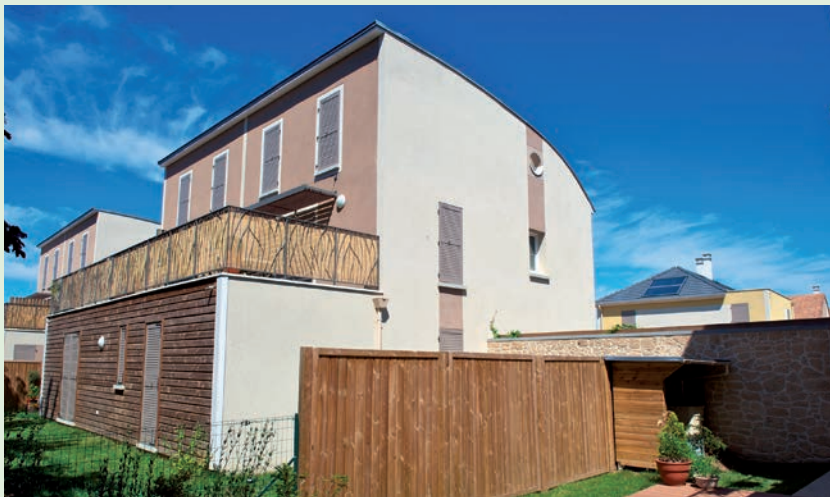
DR Une maison à ossature bois à Combs-la-Ville.
