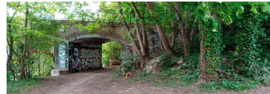
Les vestiges de l'ancien pont suspendu Ici ceux de la rive d'Étiolles. Surprise sur le parcours des berges, Un espace de destination futur ? un belvédère sur la Seine ?
