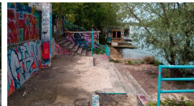
Ancienne baignade de Ris-Orangis : projet de rénovation en cours.
