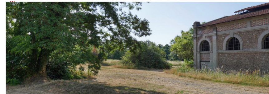
Les traces de l'ancienne activité de la pompe à eaux et la qualité des ouvrages participent au caractère exceptionnel du site. C'est un lieu dont il faut pouvoir raconter l'histoire.
