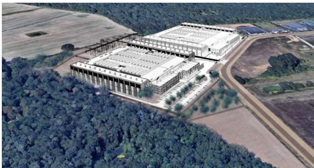
Vue d'architecte du futur data center de CloudHQ à Lisses (Essonne) (©MRAE)
