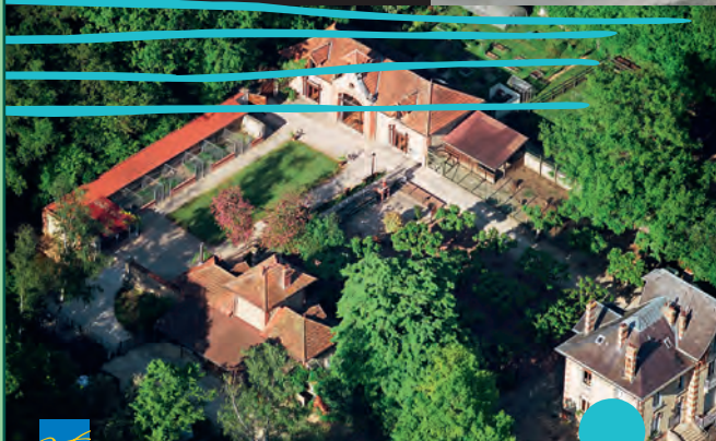
Bâtiments de la Maison de l'Environnement, 2010, Grand Paris Sud
