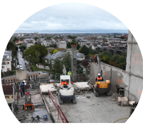
Corbeil-Essonnes : les Tarterêts en renouveau
